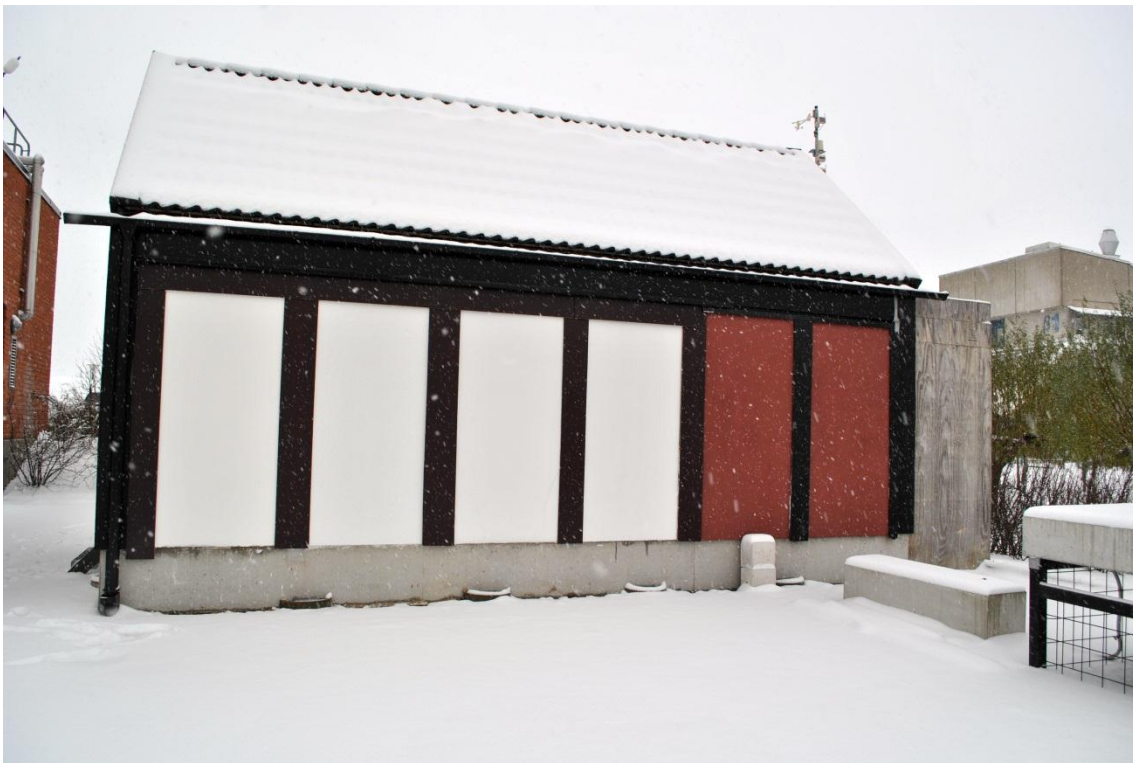
Foto 3.2.1. Provväggarna från utsidan (de vita facken).
