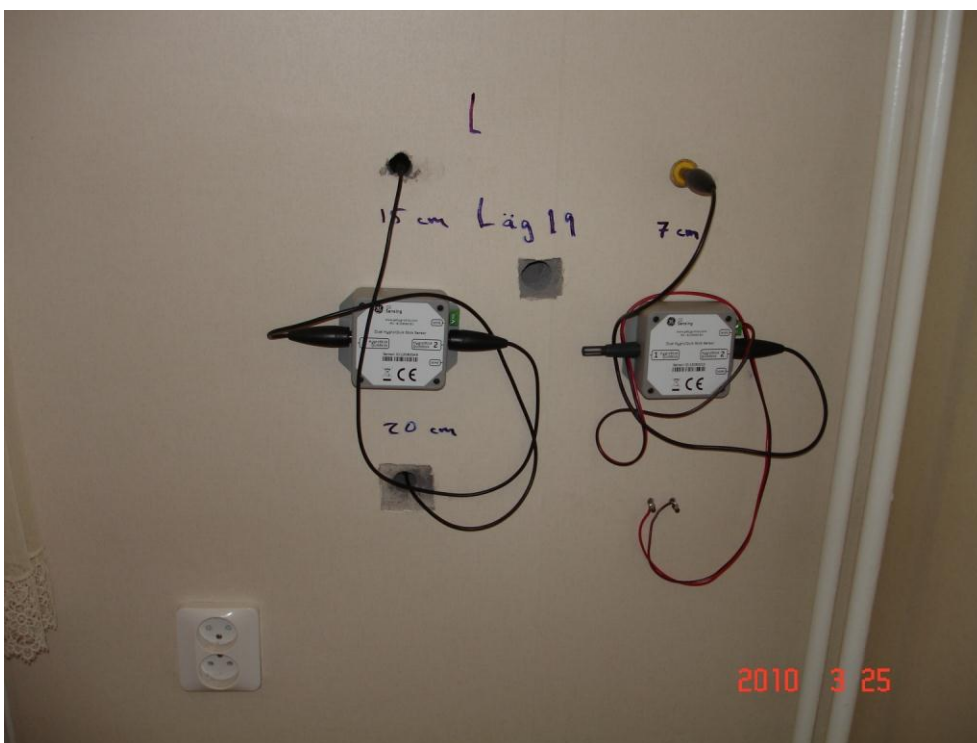
Figur 3.3.6. HygroTrac givare monterade i lägenhet B på våning 2, sydlig riktning (Foto av Kenneth Sandin, LTH).
