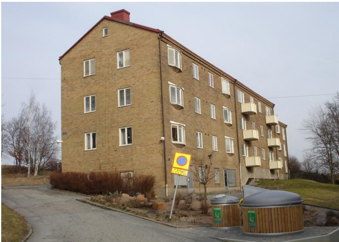
Figur 3.3.1. Den studerade byggnaden före renoveringen (Foto taget i slutet av mars 2010 av Kenneth Sandin, LTH).
